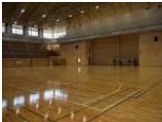
既存施設の計画的に修繕
