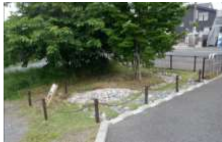
設置した雨庭(富士森公園)
