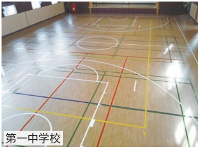
第一中学校 衝撃を吸収し足への負担軽減のほか、維持管理しやすい床材へ改修した体育館
