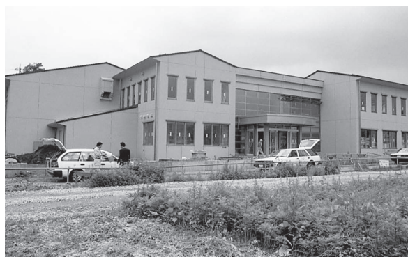
建設中の恩方市民センター
