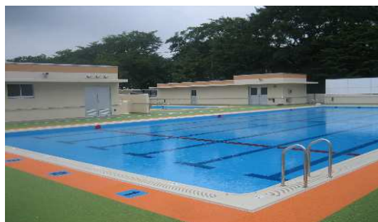
散田小学校(プール改築)
