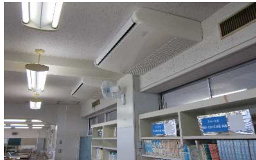
片倉台小学校(図書室空調機設置)
