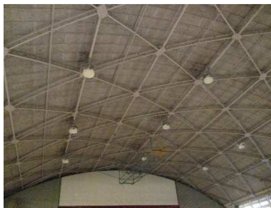
体育館照明器具の耐震化 (東浅川小学校)
