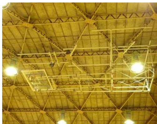
体育館バスケットゴールの耐震化 (打越中学校)
