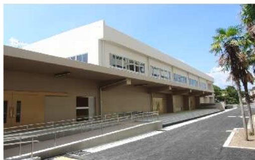
第二中学校(体育館改築)
