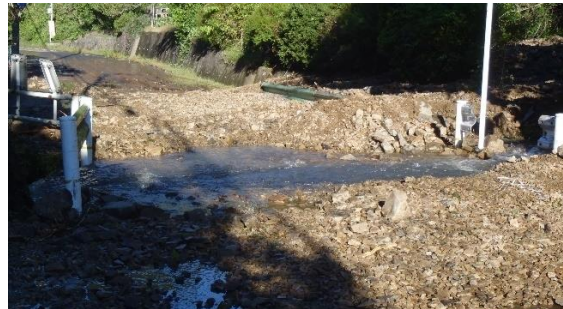
水路詰まりによる道路分断 (土砂が道路に流出)
