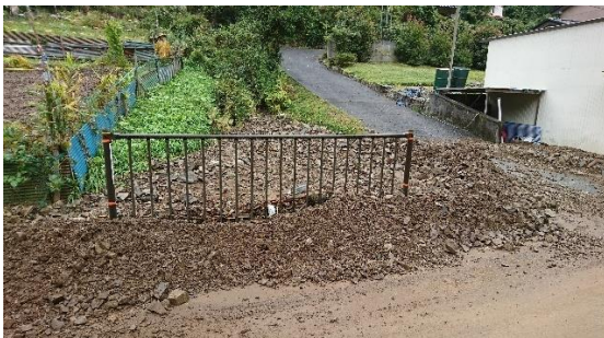
土砂堆積による水路詰まり
