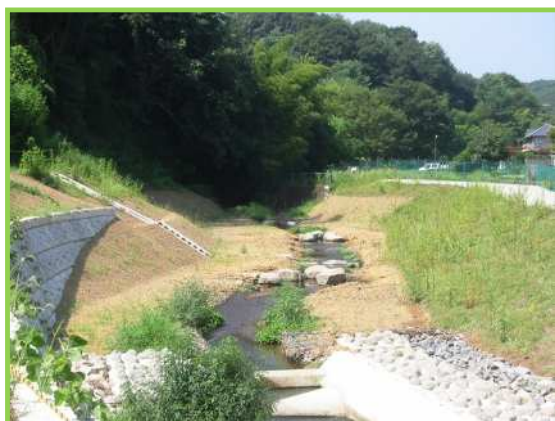
湯殿川整備（西明神橋上流）
