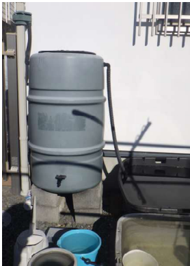
図 3-2 雨水貯留槽による雨水の有効利用の例 (八王子市内の住宅)
