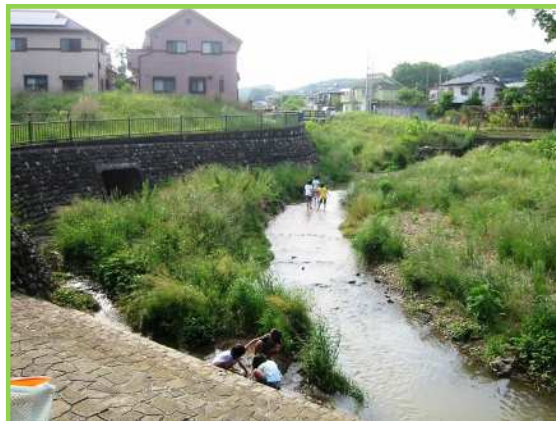
谷地川整備（宮下橋下流）
