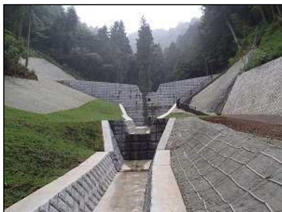
図4-45 中の沢砂防堰堤（裏高尾町）
