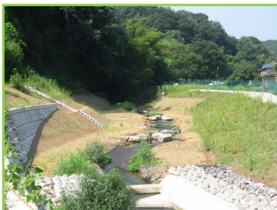
湯殿川整備（西明神橋上流）
