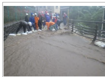
令和元年台風19号の豪雨による道路冠水
