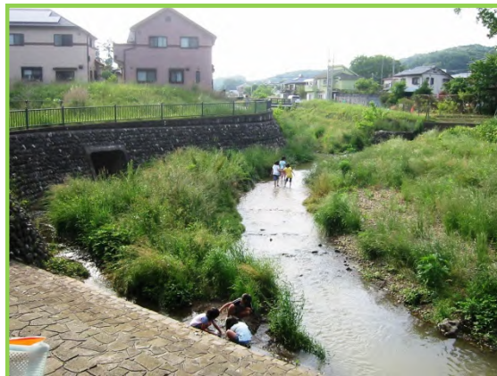
谷地川整備（宮下橋下流）
