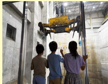
ごみを焼却炉へ運ぶクレーン (17ページ図②)
