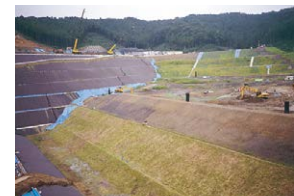
ごみを埋め立てた後、土をかぶせ、整地された斜面
