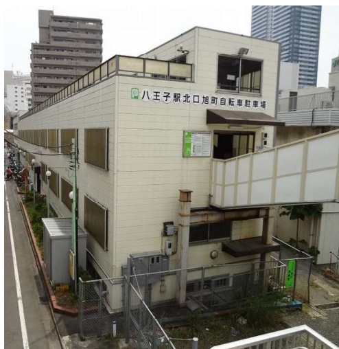
八王子駅北口有楽町線自転車駐車場
