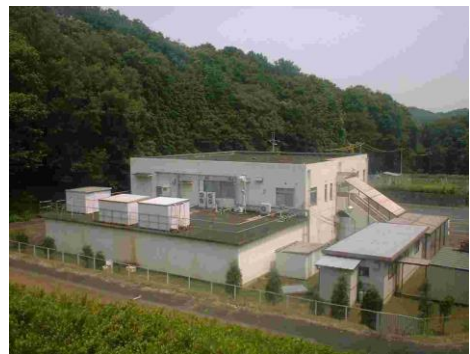
最終処分場浸出水処理施設
