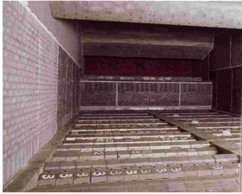
焼却炉の内部
