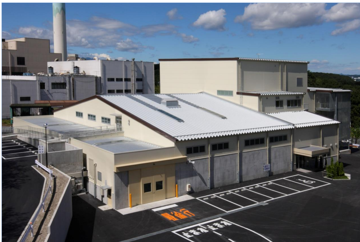
プラスチック資源化センター
