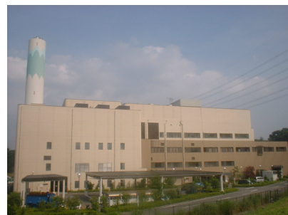
戸吹清掃工場
